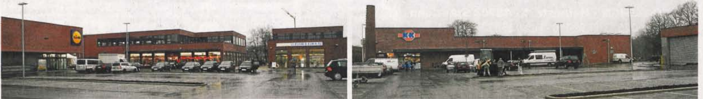
Entstanden sind auf dem geschichtsträchtigen Areal vier neue Gebäudekörper, die sich in U-Form...
